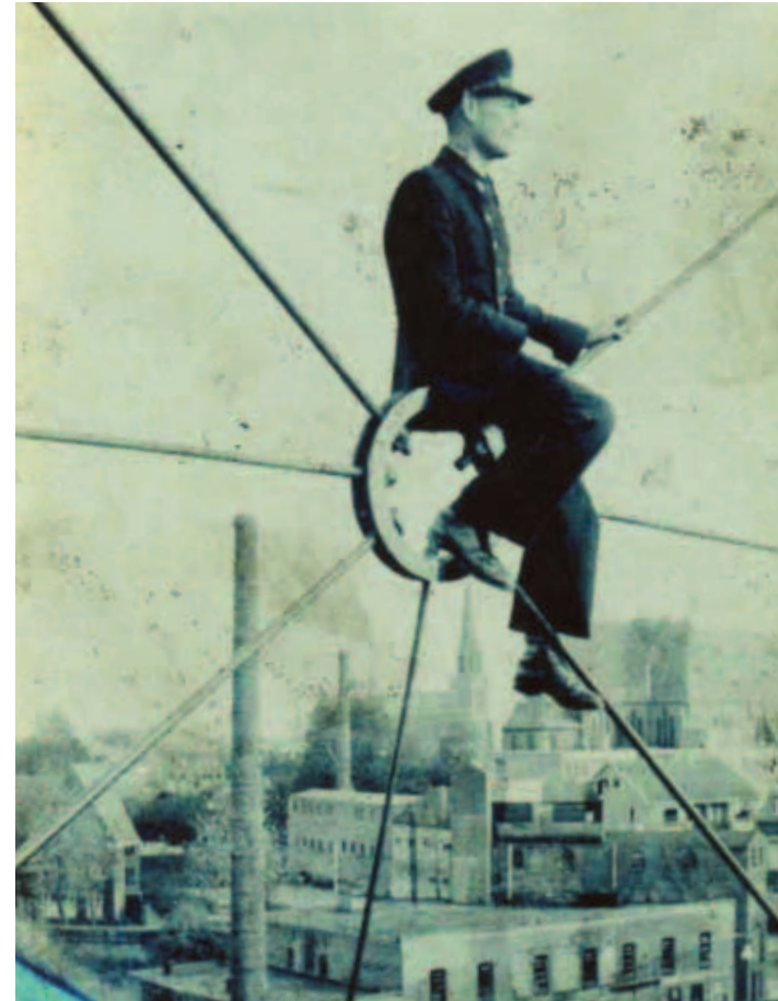
Martien van Brussel op de stalen constructie van een van de vroegere telescopische gashouders bij de gasfabriek aan de Havenweg. Op de foto zijn het voormalige textielveredelingsbedrijf 'De Watermolen', de Heilig Hart- en de Lambertuskerk te zien. (Fotocollectie Martien van Brussel)
